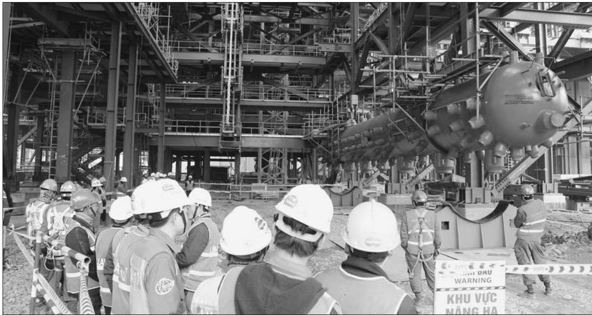
Lắp đặt thiết bị tại Nhà máy Nhiệt điện Mông Dương 1
